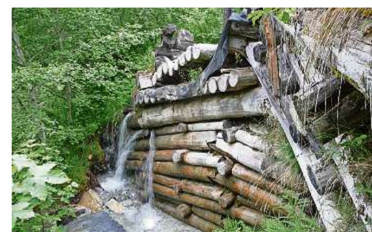
Eine von drei errichteten Wildbachsperrn zum Schutz der Pignuerstrasse in Ilanz. (ZVG)
